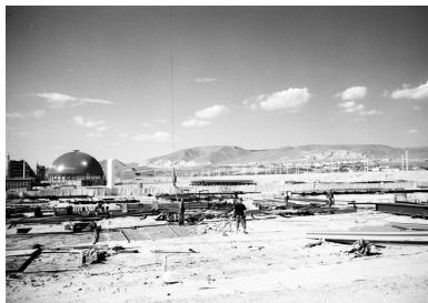
写真-25 建設中の石炭液化プラント
