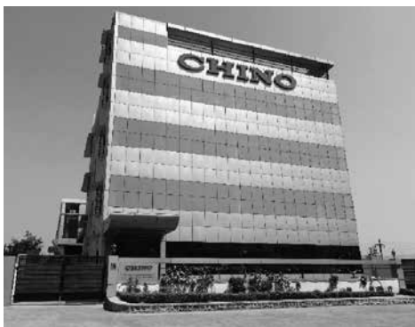
(チノールのムンバイ工場外観)
