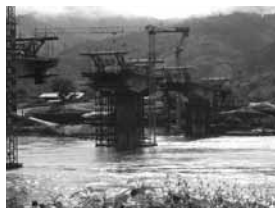
写真2：第4メコン国際橋の工事
