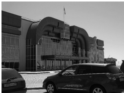
写真-22 出入国管理施設
