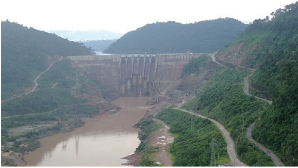
図7 稼働を始めたナムトゥン1ダム・発電所（中部）
