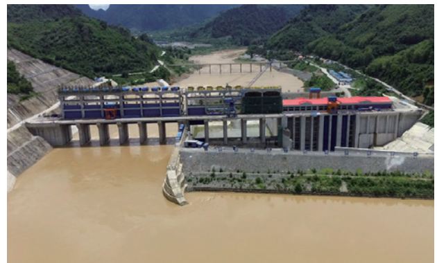
図6 中国企業建設のNam Ou1水力発電所（北部）
