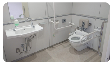
SPOT 5 3号館1階 左勝手 入口手動ドア/手すり/ パウチ・しびん洗浄水栓/鏡付き手洗い
