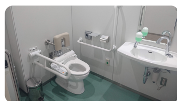
SPOT 6 5号館1階 右勝手 入口手動ドア/手すり パウチ・しびん洗浄水栓/鏡付き手洗い
