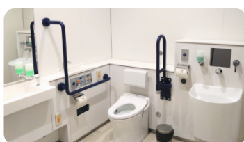
SPOT 2 1号館2階 左勝手 入口自動ドア/手すり/鏡付き汚物流し 着替え台/鏡付き手洗い/ベビーチェア おむつ換え台
